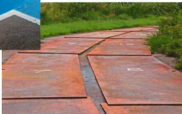
建築現場の敷鉄板
