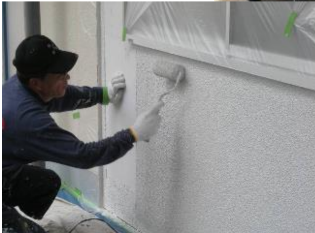
写真① 外壁塗装
