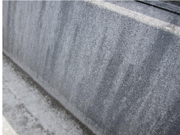
他社品G 3年経過後(汚染・破断発生)
