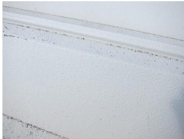
断熱コートEX 3年経過後(汚染・破断なし)
